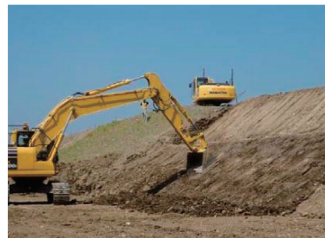
セミオート制御による施工【法面整形】(ICT建機)
