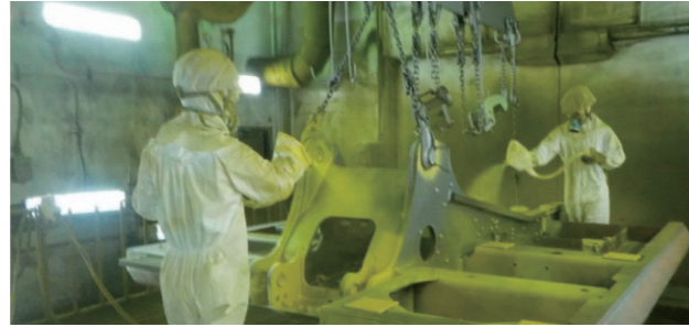
塗着効率の良い塗料を用いた大阪工場の塗装風景
