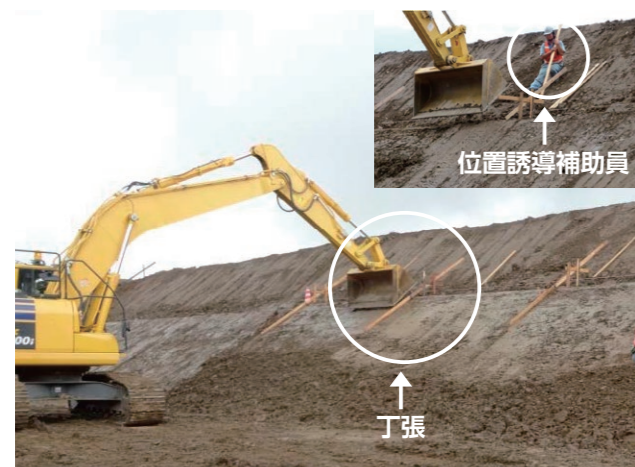
丁張を目視して手動操作する施工(従来)
