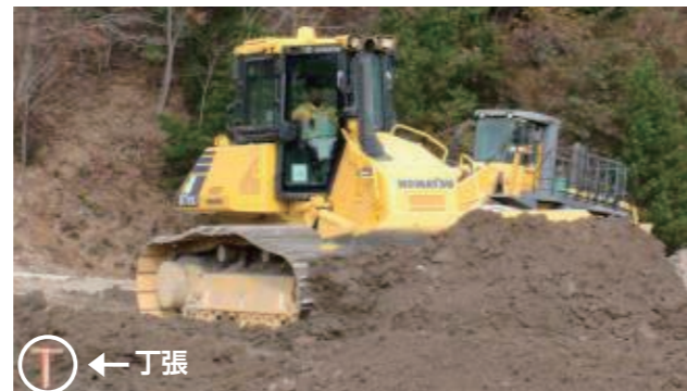
丁張を目視して手動操作する施工(従来)
