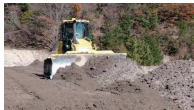
全自動ブレード制御による施工(ICT建機)
