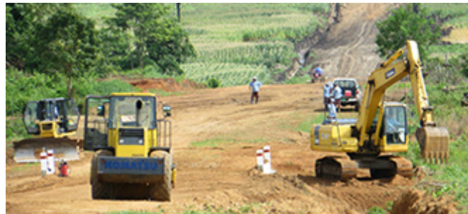
道路建設の様子
