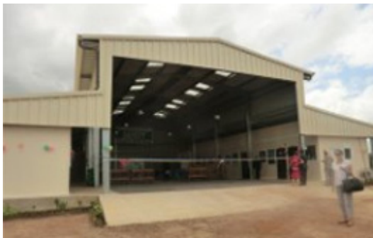
2014年6月、リベリアに開設された施設 「Japan Heavy Duty Equipment Operator School(JHDEOS)」
