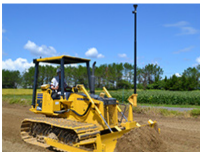
ICTブルドーザーによる整地作業
