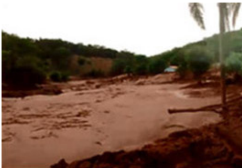
決壊したダムの様子
