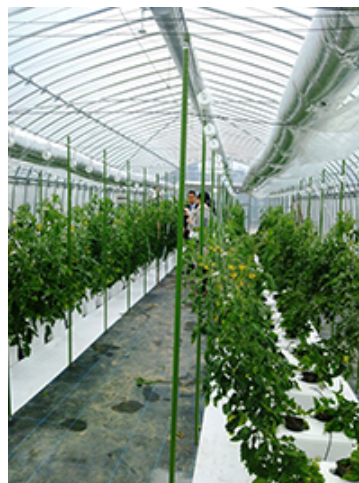
地下水冷風ダクトを配置したトマト栽培ハウス
