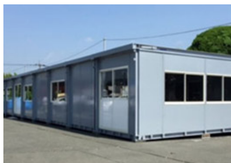
仮庁舎として設置した仮設ハウス
