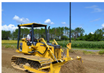
ICTブルドーザーによる整地作業
