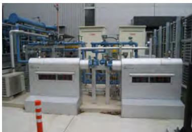
水冷式ヒートポンプ空調システム
