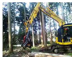
コマツハーベスタによる材の伐倒・造材作業
