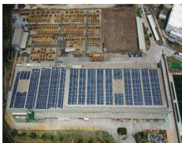
2018年度：設置されたソーラールーフ（920.7 kW）
