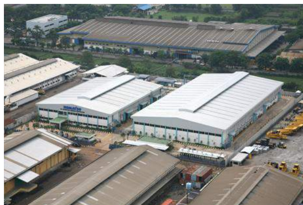
コマツインドネシア工場内 リマンセンタ
