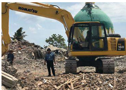
ロンボク地震被災地で稼働する油圧ショベル
