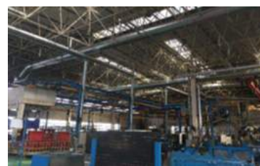
中国での規制対応例（大京機械山東有限公司：溶接ヒューム用集塵機・排気ダクトの設置）
