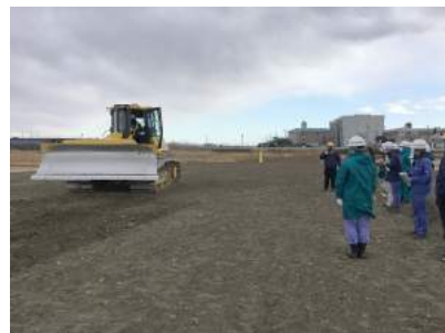
ICT建機使用方法施悦明会の状況
