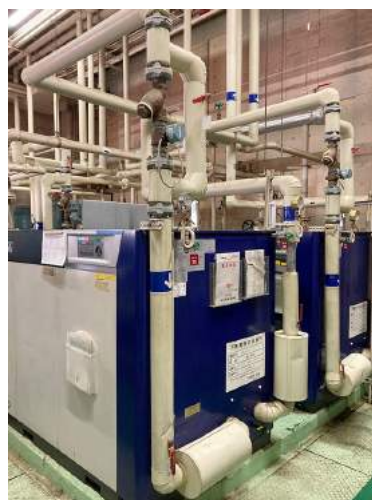
コンプレッサー設備
