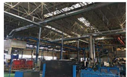
中国での規制対応例（大京機械山東有限公司：溶接ヒューム用集塵機・排気ダクトの設置）
