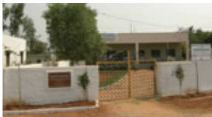
2008 年 9 月に完成したディアバラハリ村小学校の新校舎
