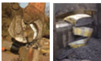
カウンターウエイト解体実証実験。 左はラバンティシャーによる工法、 右はギロチンシャーによる工法
