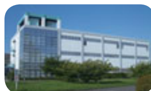
コマツ・ハイブリッド・システムの構成コンポーネントを製造する湘南工場
