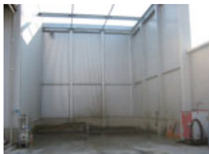
囲いを高くすることで、洗車時の音や水などの周辺への影響が小さくなるよう配慮した洗車場（コマツレンタル福岡西店）
