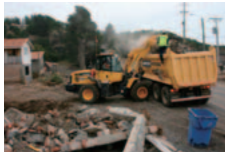
瓦礫をダンプトラックに積み込む
