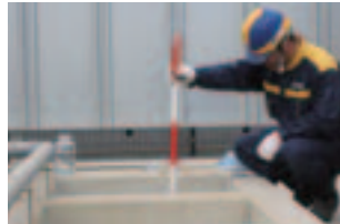
洗車場の油水分離槽の点検 (コマツレンタル 郡山店)
