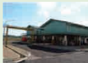
BDF製造パイロットプラント
